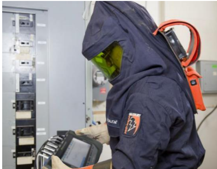
Şekil 1: Taşınabilir güç kalite analizörü, koruyucu ekipman giysisi giyen bir elektrikçi tarafından kuruluyor.
